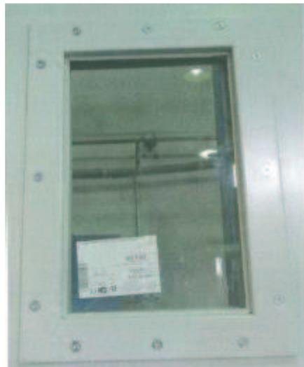
Vue du cadre de montage et des boulons de fixation du vitrage (côté intérieure)
