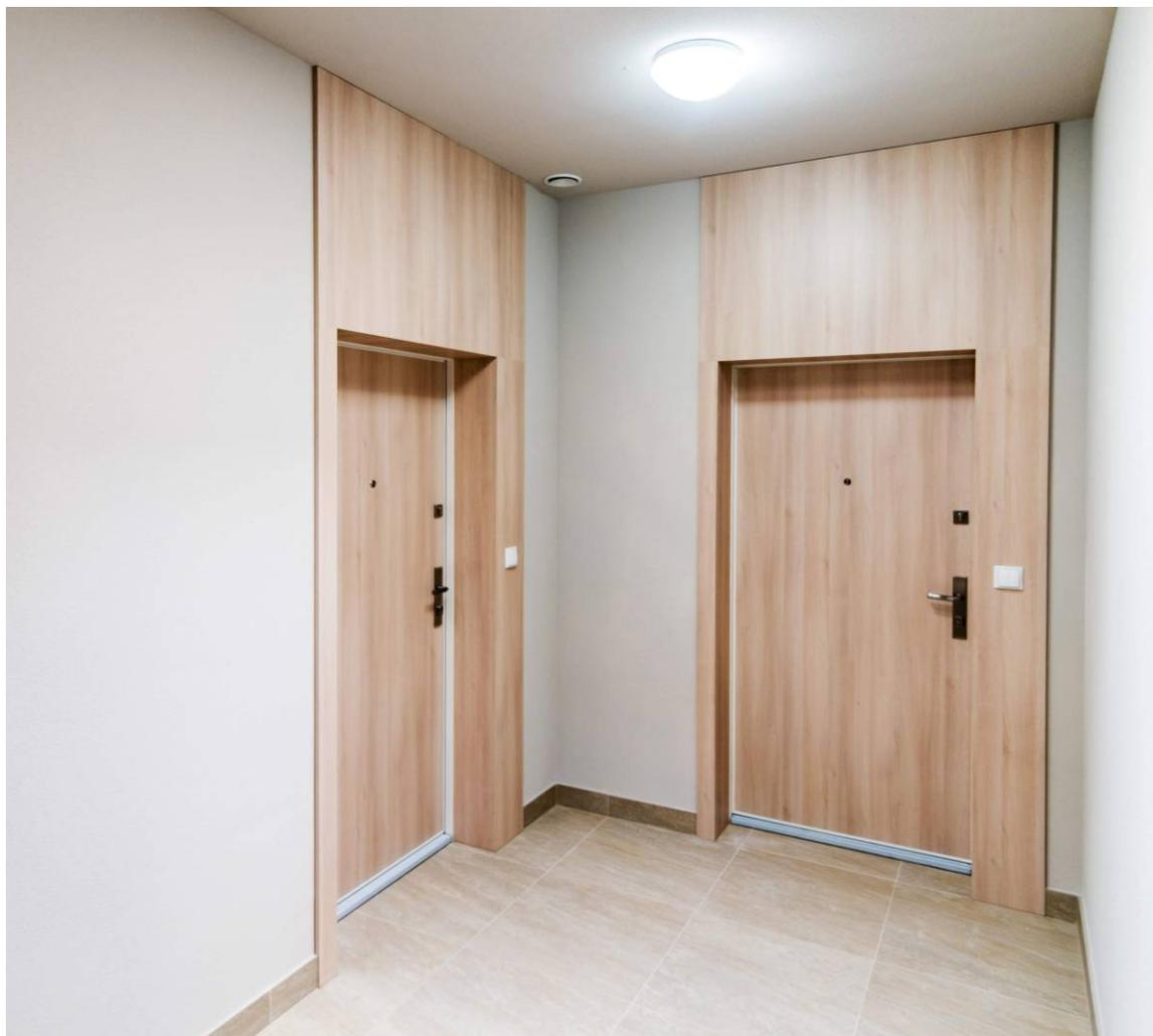
Vantail de 60mm d'épaisseur en tôles acier galvanisé d'épaisseur 1 mm assemblées par clinchage, renforcé en profils en forme de C, isolé de laine de roche et équipé de pions anti-dégondage. Dormant d'angle en tôle acier galvanisé d'épaisseur 1,5mm, sans soudures apparentes, laqué en teinte RAL au choix. Paumelles réglables 3D soudées et laquées. Porte classée anti-effraction RC3.
