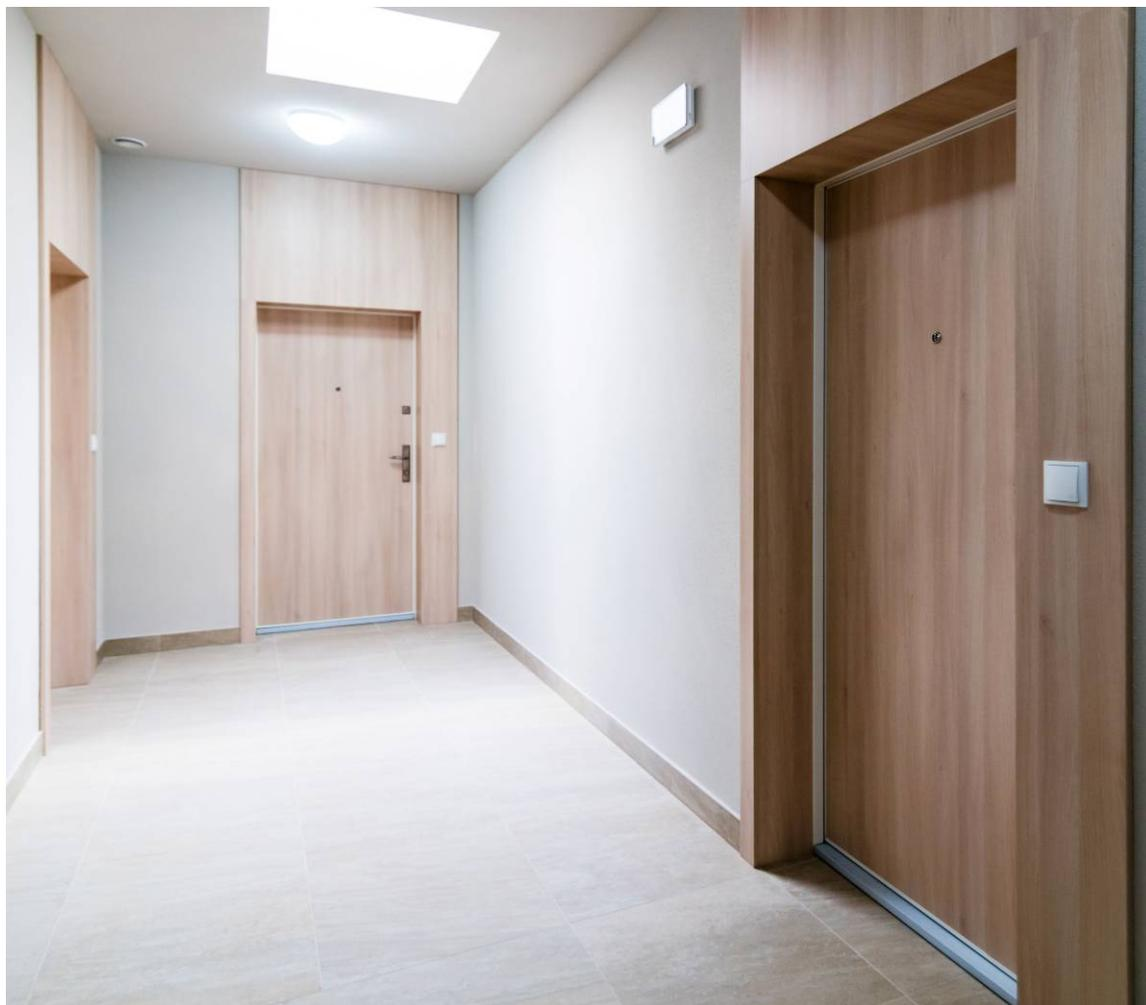
Vantail de 60mm d'épaisseur en tôles acier galvanisé d'épaisseur 1 mm assemblées par clinchage, renforcé en profils en forme de C, isolé de laine de roche et équipé des pions anti-dégondage. Dormant d'angle en tôle acier galvanisé d'épaisseur 1,5mm, sans soudures apparentes, laqué en teinte RAL au choix. Paumelles réglables 3D soudées et laquées. Porte coupe-feu équipée d'une paumelle supplémentaire à fermeture automatique. Porte classée anti-effraction RC3.
